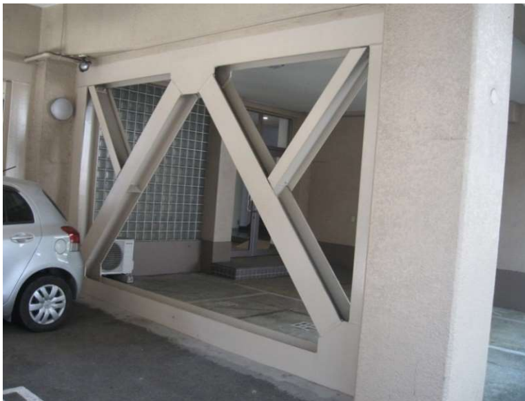
1階の駐車場の補強
