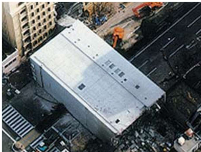
建築物の倒壊による 道路閉塞
