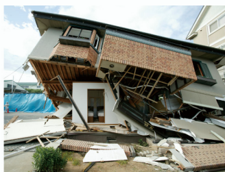
倒壊実験写真
