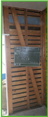
①既存壁の撤去
