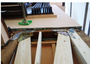
通し柱補強（室外より）
