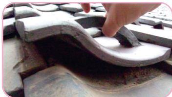
屋根瓦の葺き土の有無を調査
