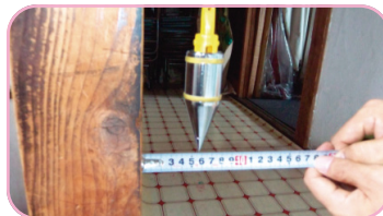
下げ振りで柱の傾きを調査
