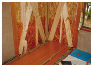
押入れ内補強
