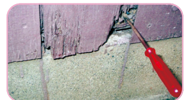
土台の腐朽度合いを調査
