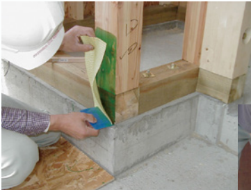
柱脚補強 (30cmシート1枚貼り)
