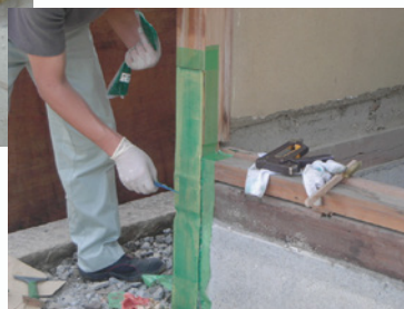
柱脚補強 (70cmシート1枚貼り)
