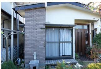
フレーム完成
