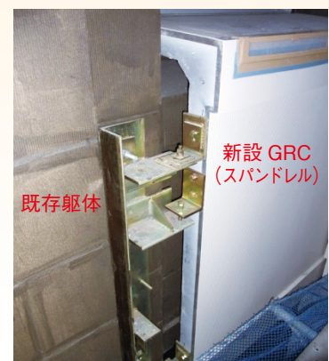
新設GRC取付け状況 (2)
