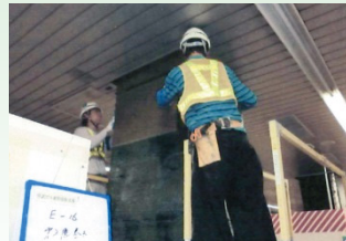
炭素繊維シート巻き付け
