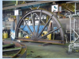
車輪型ブレース製作状況
