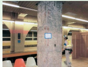
既存躯体目荒し
