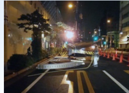
車輪型ブレース現場搬入
