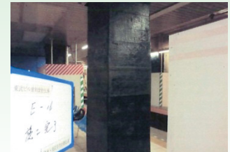
炭素繊維補強完了
