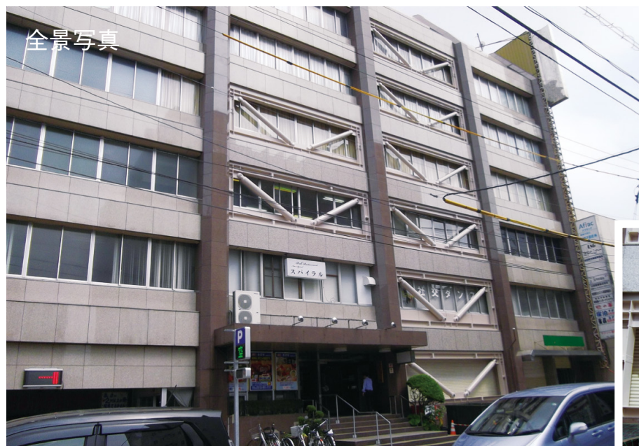
A D座屈拘束ブレース写真
