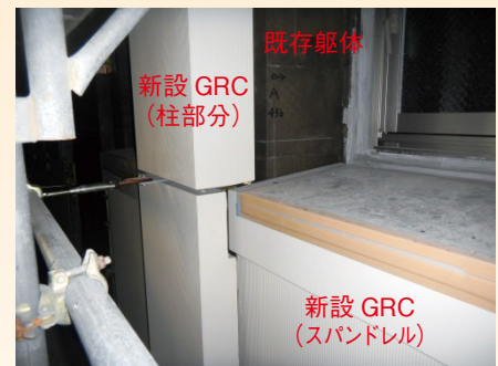
新設GRC取付け状況 (1)
