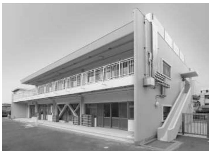
写真 保育所の耐震改修事例
