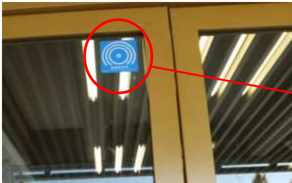
写真 耐震マーク掲示風景
