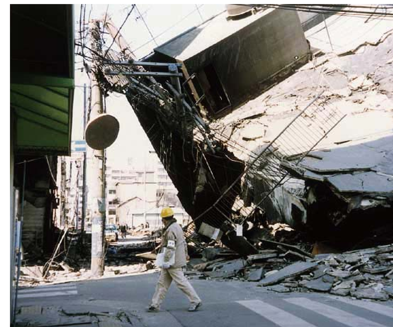
沿道建築物の倒壊による道路閉塞（阪神・淡路大震災）
