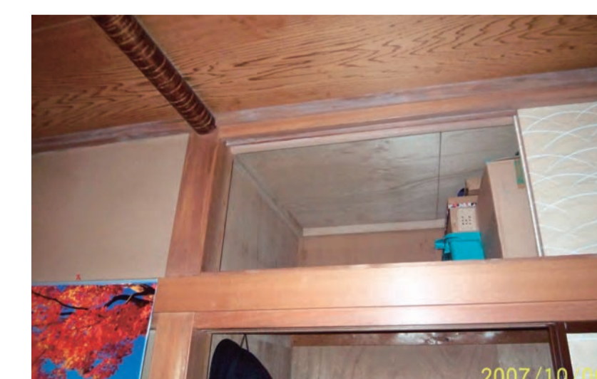
押入れの天井板を外して、屋根裏を調査
