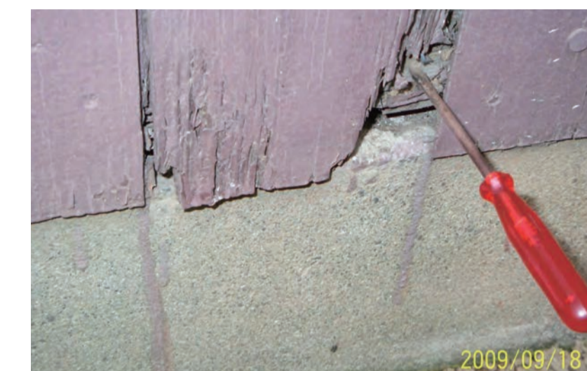
土台の腐朽具合を調査
