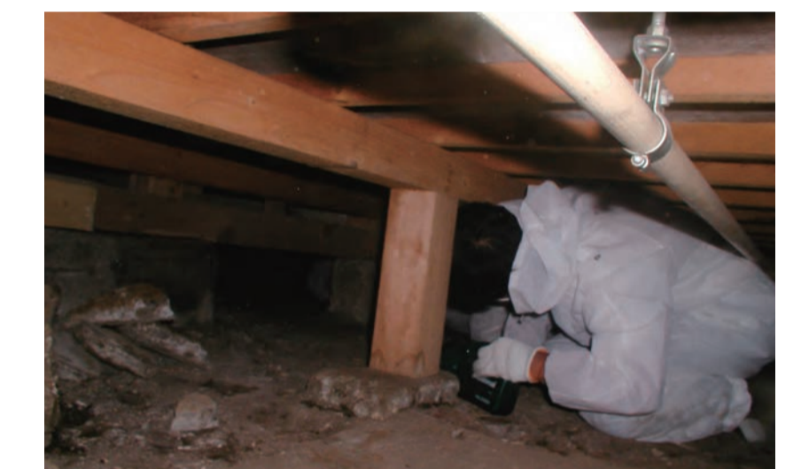
床下から湿潤状態や部材の腐朽、シロアリ被害の有無を調査
