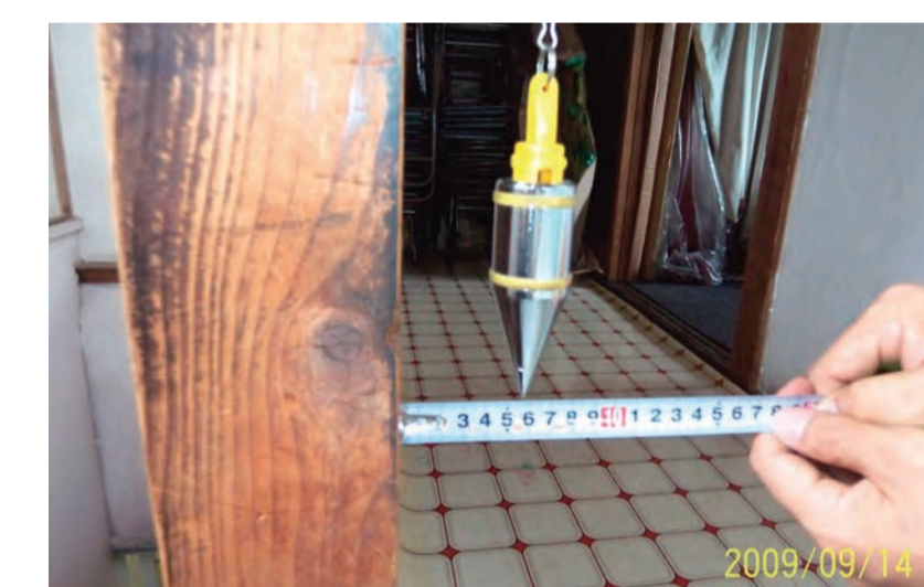
下げ振りで柱の傾きを調査
