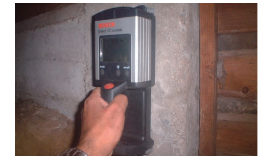
鉄筋探査機で基礎の鉄筋の有無を調査
