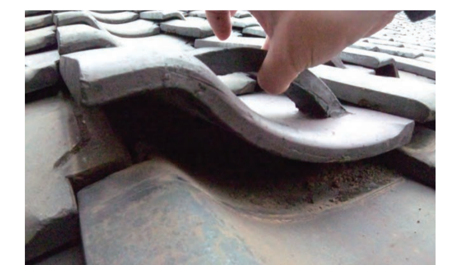
屋根瓦の葺き土の有無を調査
