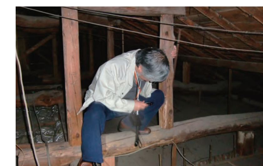
小屋裏から土壁の状況を調査
