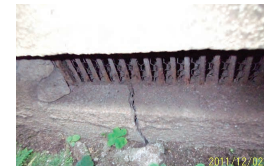
基礎のひび割れを調査
